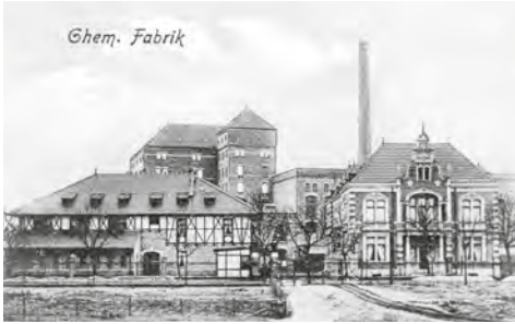
Chemische Fabrik, 1894 / Chemical Factory 1894 © Verlag Max Krusche, Finow
