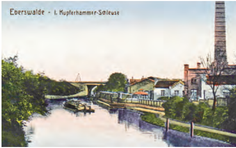
Kupferhammer, 1603 / Copper Hammer 1603
