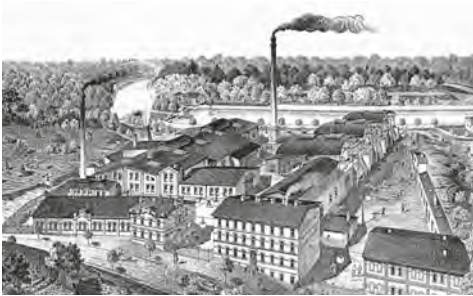
Rohrleitungsfabrik, 1898 / Pipeline Factory 1898
